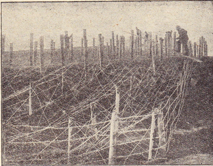
Fils de fer barbelés, protégeant l'accès d'un fort.
